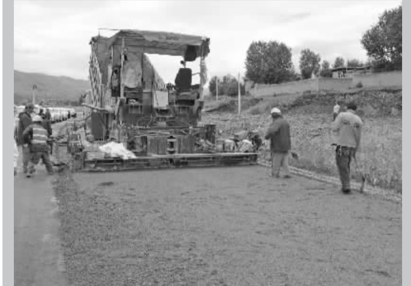
省道217线雅州路路面摊铺施工现场。
