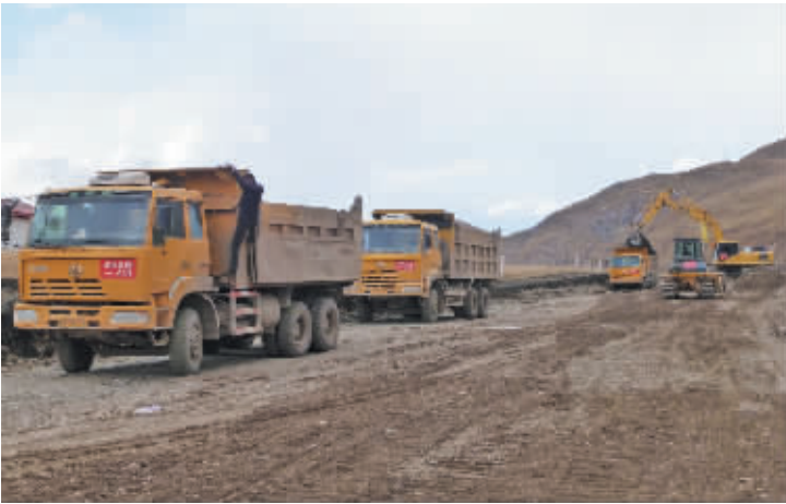
▲一派繁忙的317线施工现场。
