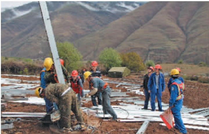
▲新甘石施工人员正在施工。
