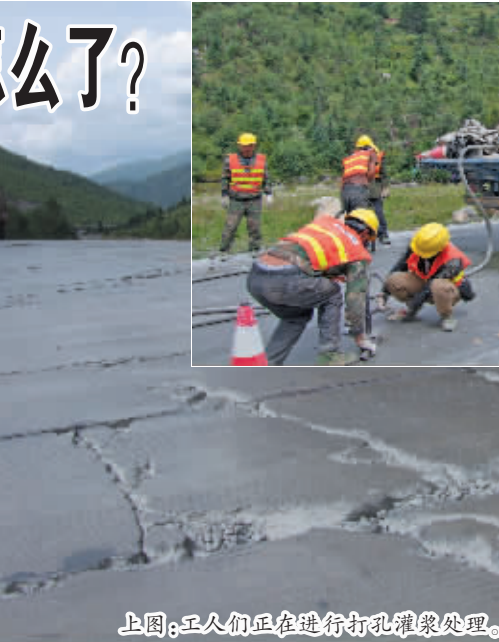
上图:工人们正在进行打孔灌浆处理。下图:路面出现的裂缝。
