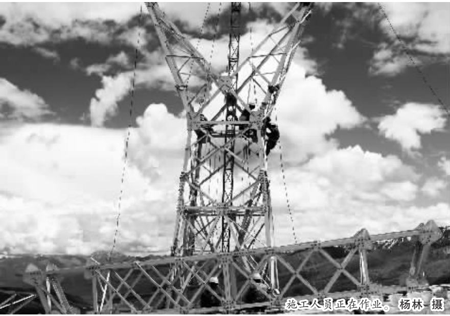
施工工人正在作业。杨林 摄
