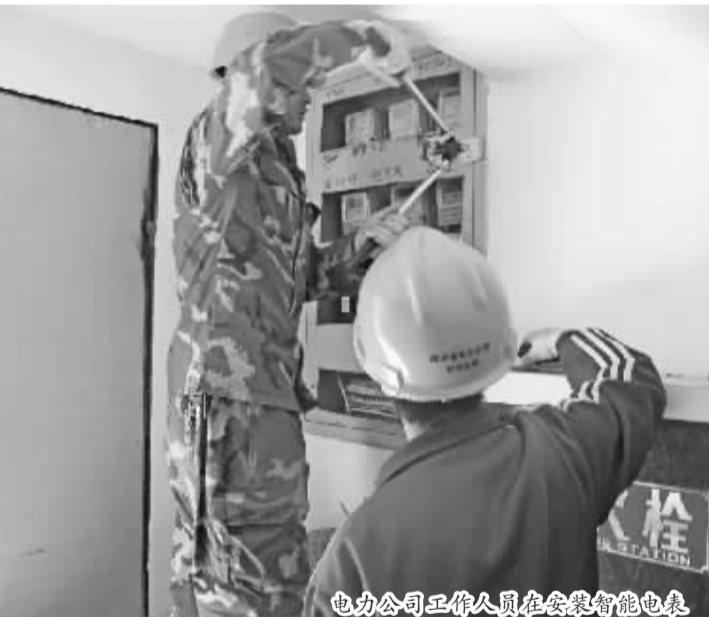
电力公司工作人员在安装智能电表
