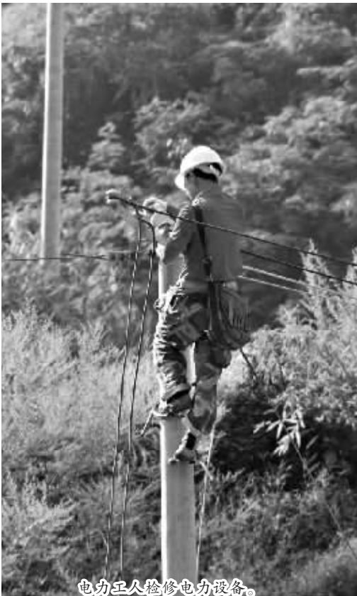
电力工人检修电力设备。
