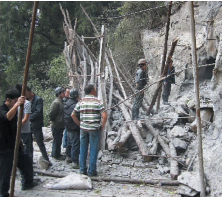
近日,康定县孔玉乡针对折路电站引水隧洞爆破对山体结构和周围民房是否存在影响问题,特邀请西南交大工程爆破研究所电站引水隧洞现场进行爆破试验,同时邀请折路村部分村民代表现场监督爆破试验全程。试验所取得的科学论证将是维护群众合法权益的参考数据。图为爆破现场。(曾奇 摄影报道)
