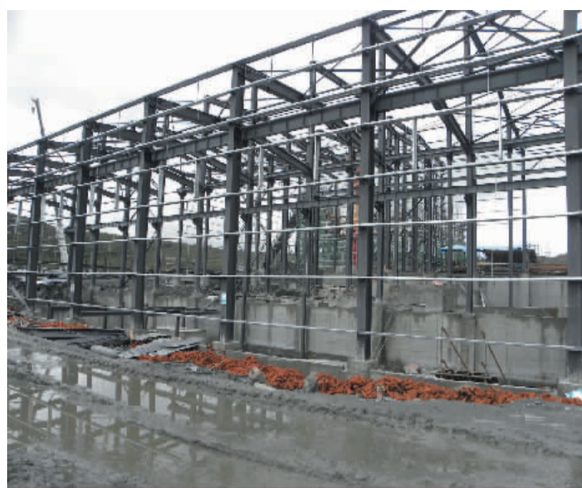
矿山建设现场。
