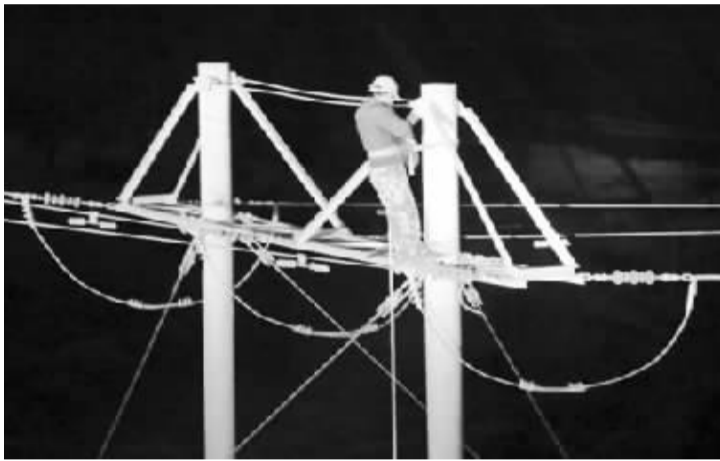
抢险人员在现场作业。
