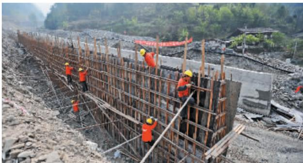
芦山地震灾区宝兴县加快治理冷水沟地质灾害隐患点，预计5月底前可全部完工。图为4月15日，施工人员在冷水沟泥石流综合治理工地上修筑排导槽。 新华社发
