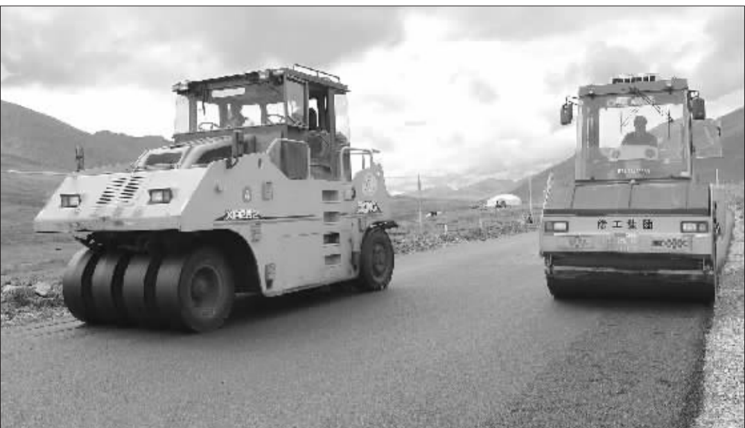
路面建设现场。
