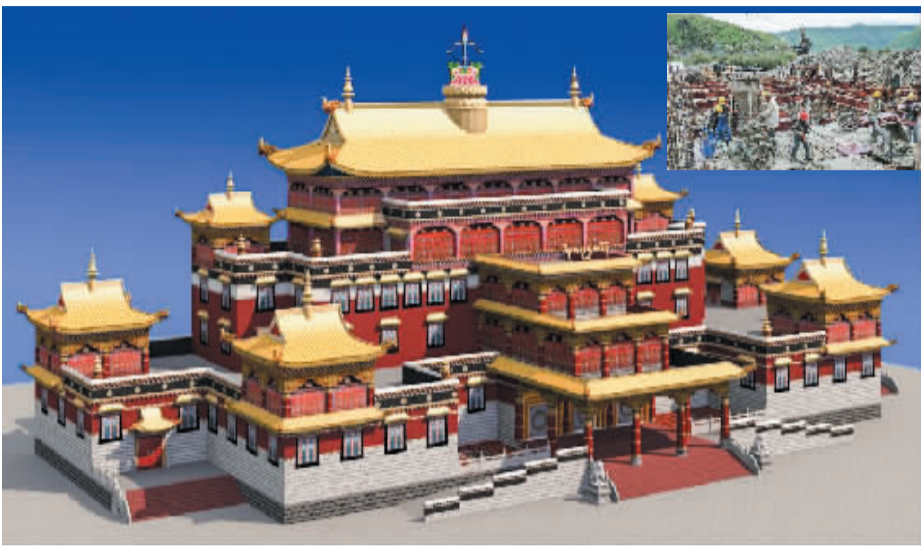
图为德格县格萨尔展览馆效果图及建设工地。
