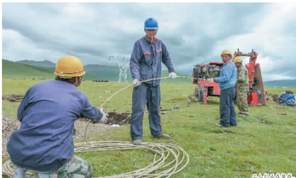
工人们正在架线。
