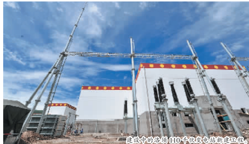
建设中的洛须110千伏变电站新建工程。
