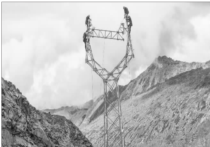
电力员工在波密乡境内海拔5100米施工地城安装铁塔。
