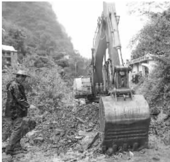
使用大型机具清除淤泥阻塞。
