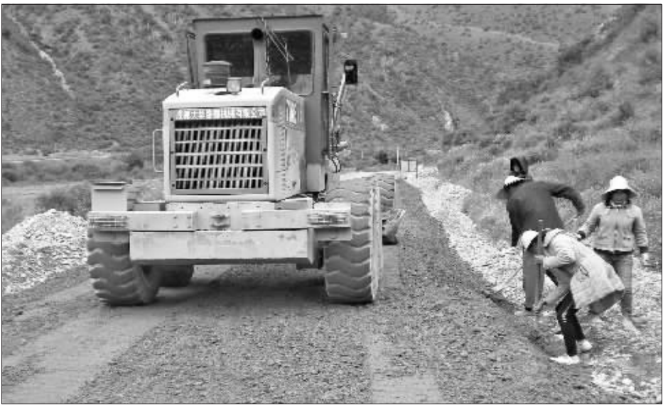
正在建设中的通村公路。
