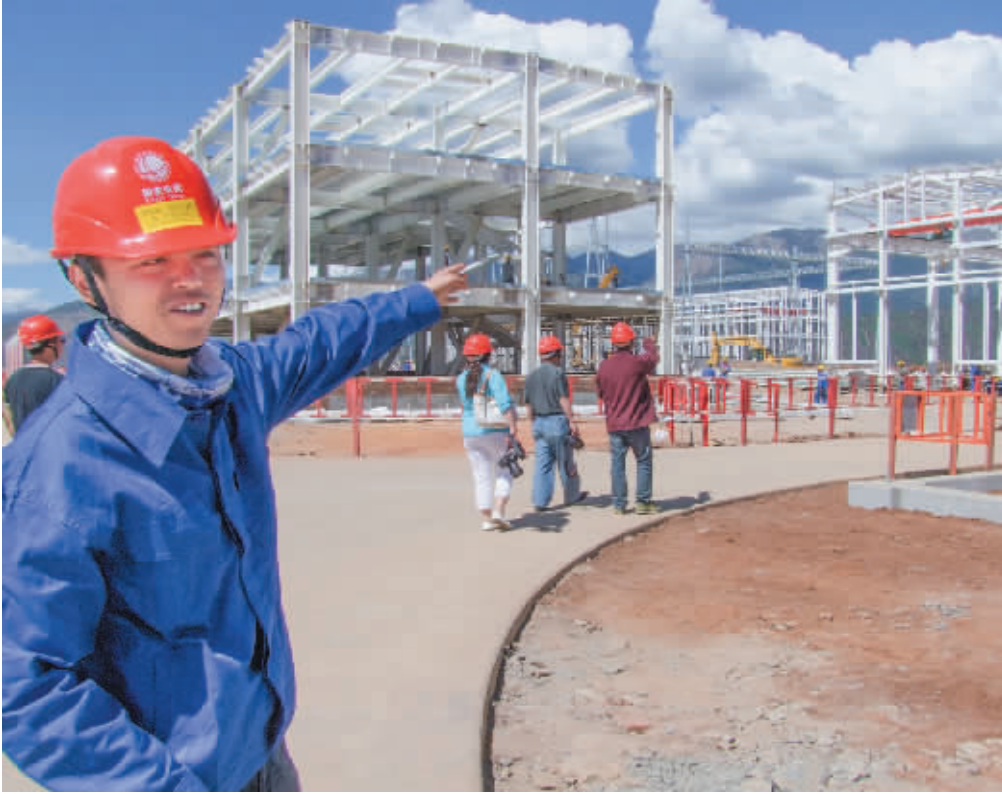
巴塘500千伏变电站建设负责人介绍建设情况(本报记者宋志勇摄)
