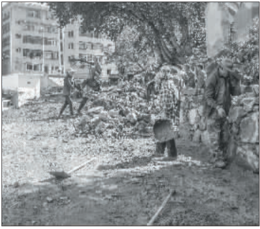
公主桥段施工现场。
