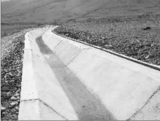
通水试运行的新水渠。
