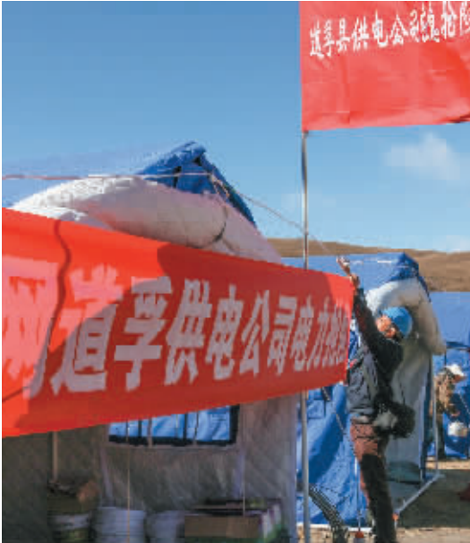
▲国电员工为帐篷安电灯。
