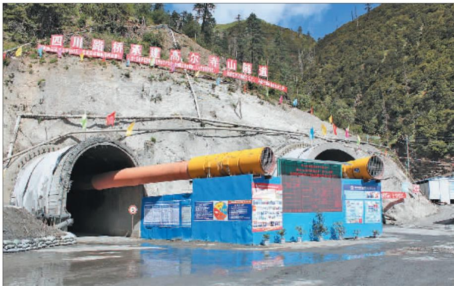
截止12月4日，高尔寺隧道开挖掘进顺利突破5000米大关（主洞和平洞均分别开挖掘进5040米）。据工程负责人介绍，隧道力争在2015年3月底实现开挖贯通，8月底正式投入运营。G318线东海路高尔寺隧道全长5682米，穿越海拔4200余米的高尔寺山，连接康定、雅江两县。该隧道是国道318线东海路改建工程的控制性工程，建成后缩短里程21KM，可以节省通行时间40余分钟。（刘赞文 王丹婷 摄影报道）
