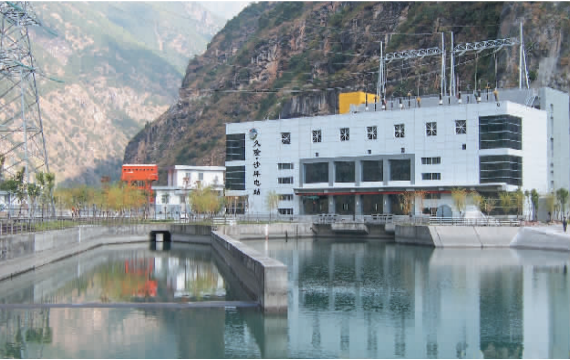
沙坪电站厂房外景。(本报资料图片)
