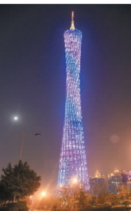
廣州市電視塔。
