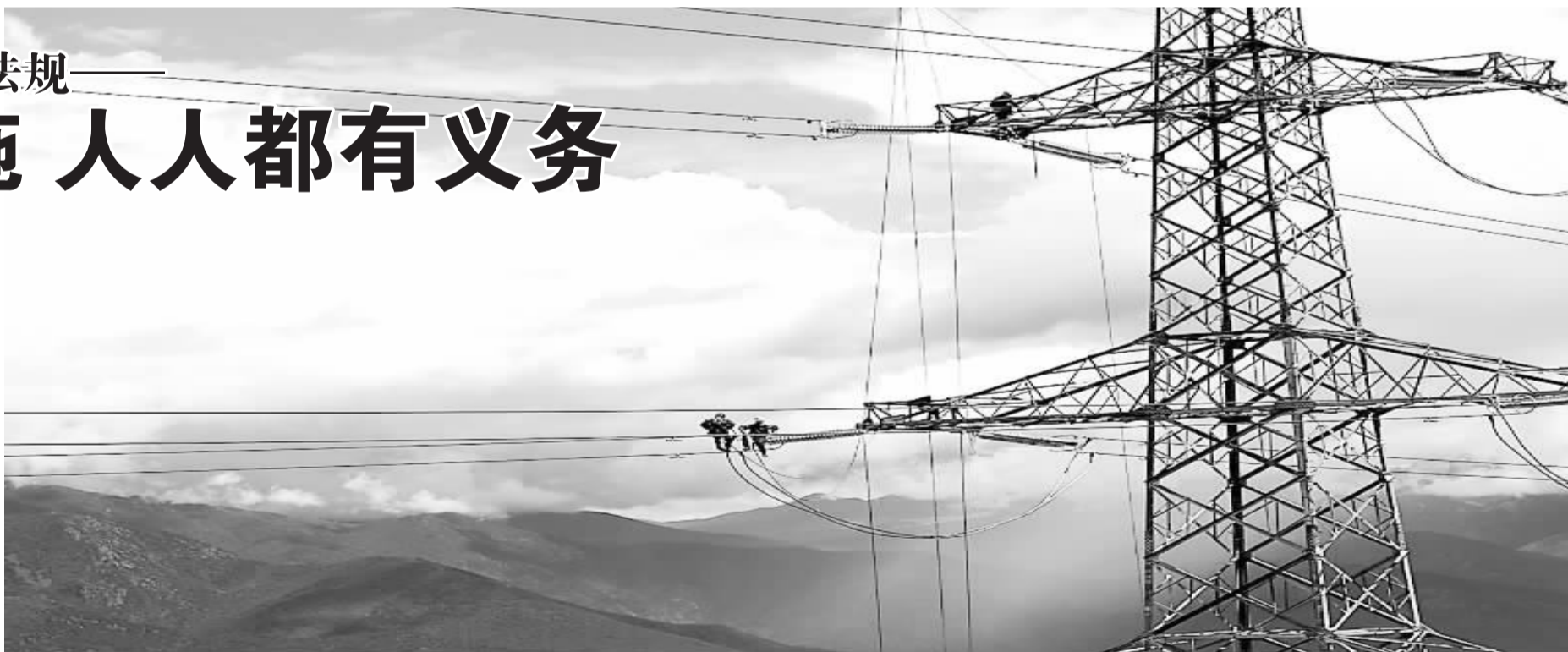
500千伏川藏联网工程铁塔。
