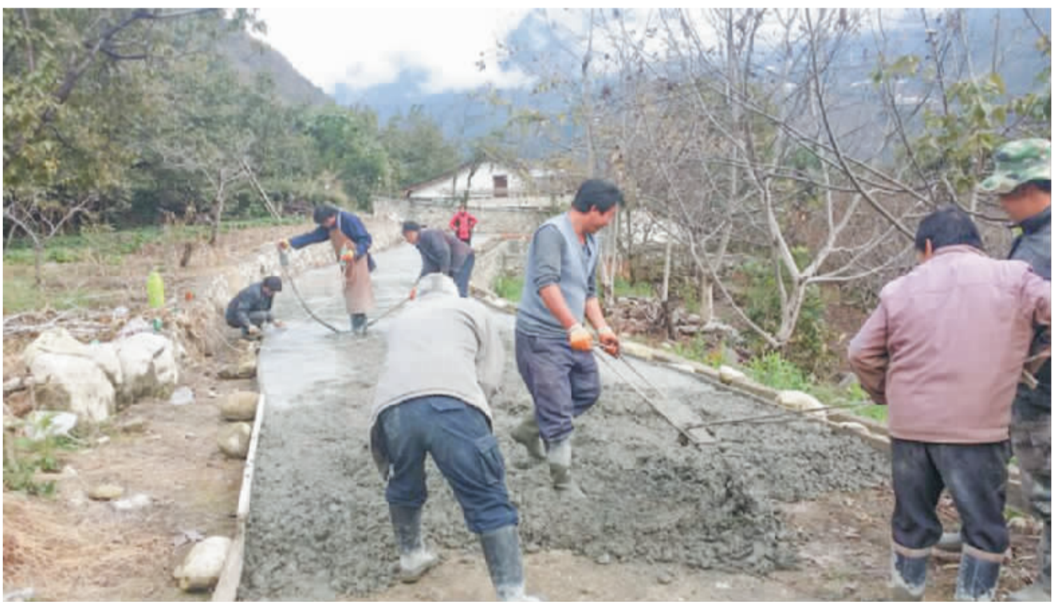
群众投工投劳修筑幸福路。
