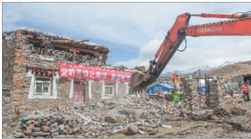
康定县灾后恢复重建现场。
