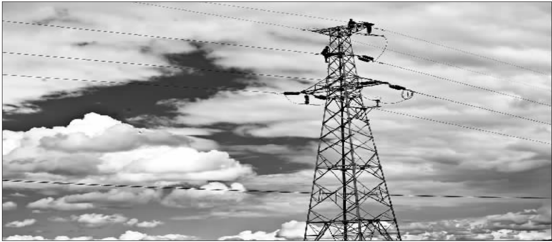
甘投“电力天路”工程。
