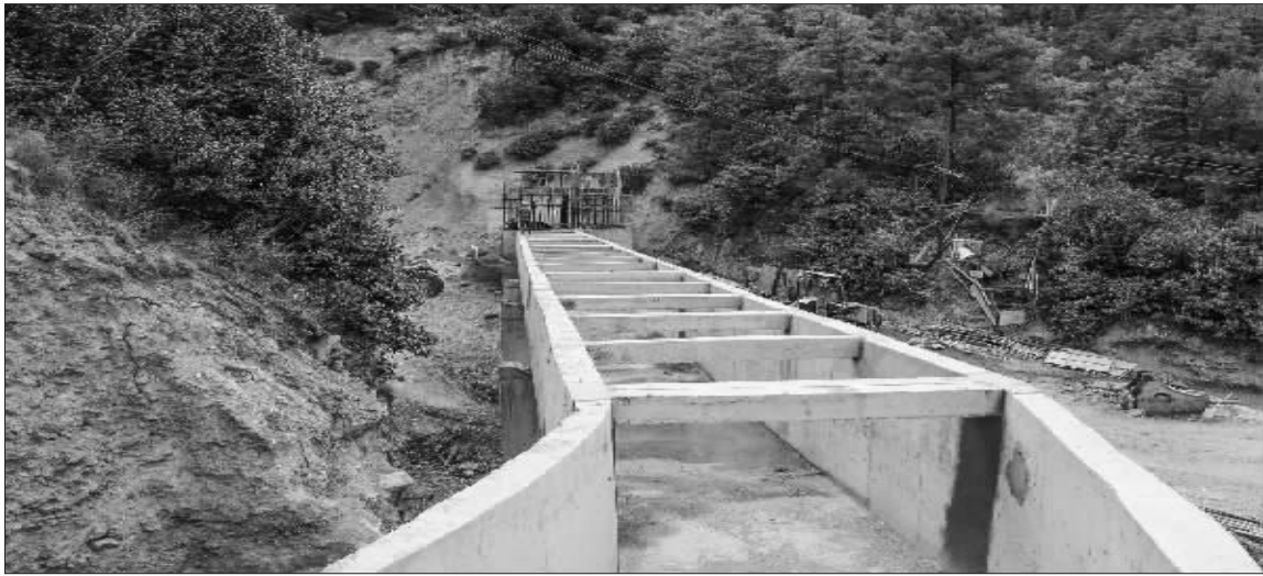
即将完工的主干渠。
