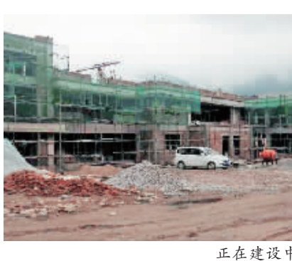
正在建设中的得安乡发旺小学。
