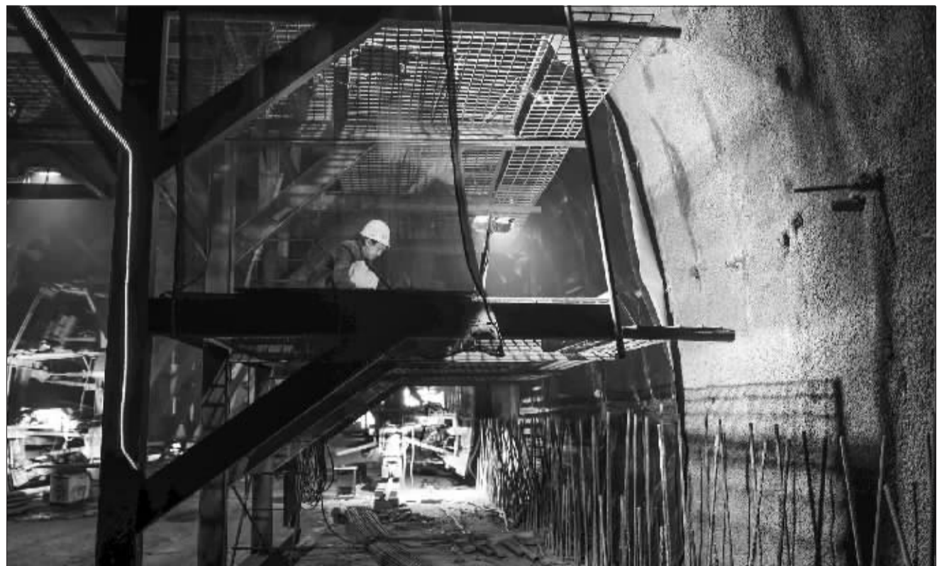
雅康高速公路飞仙关特长隧道工地上施工。新华社发
