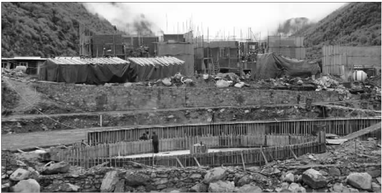
建设中的康定中谷村集中安置点。
