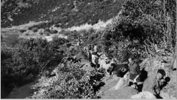
安全饮水槽开工现场。
