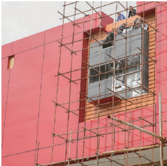
工人们正在修建博物馆。
