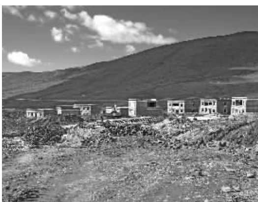
康定巴巴村集中安置点建设现场。
