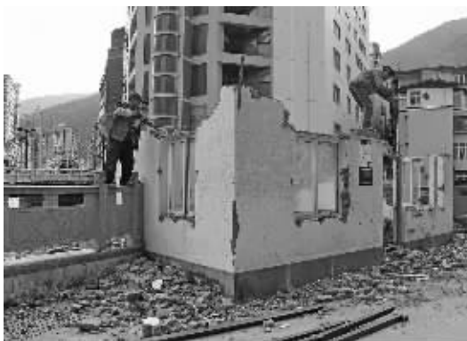
正在拆除的州医院郭达街交界处违建建筑。
