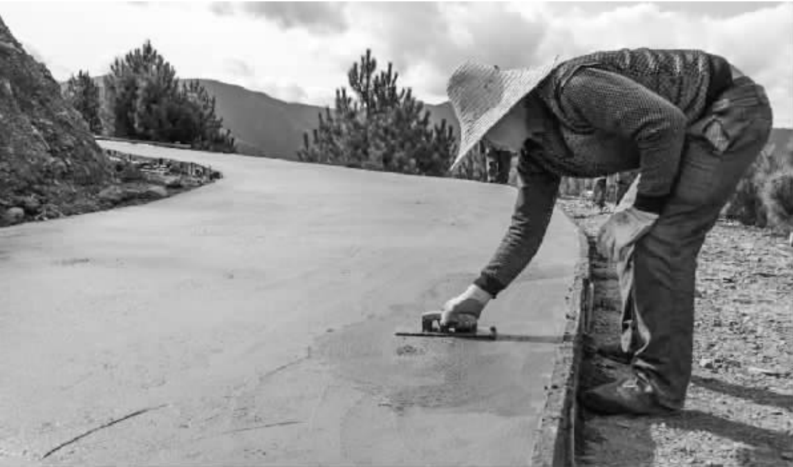
修建通村公路。
