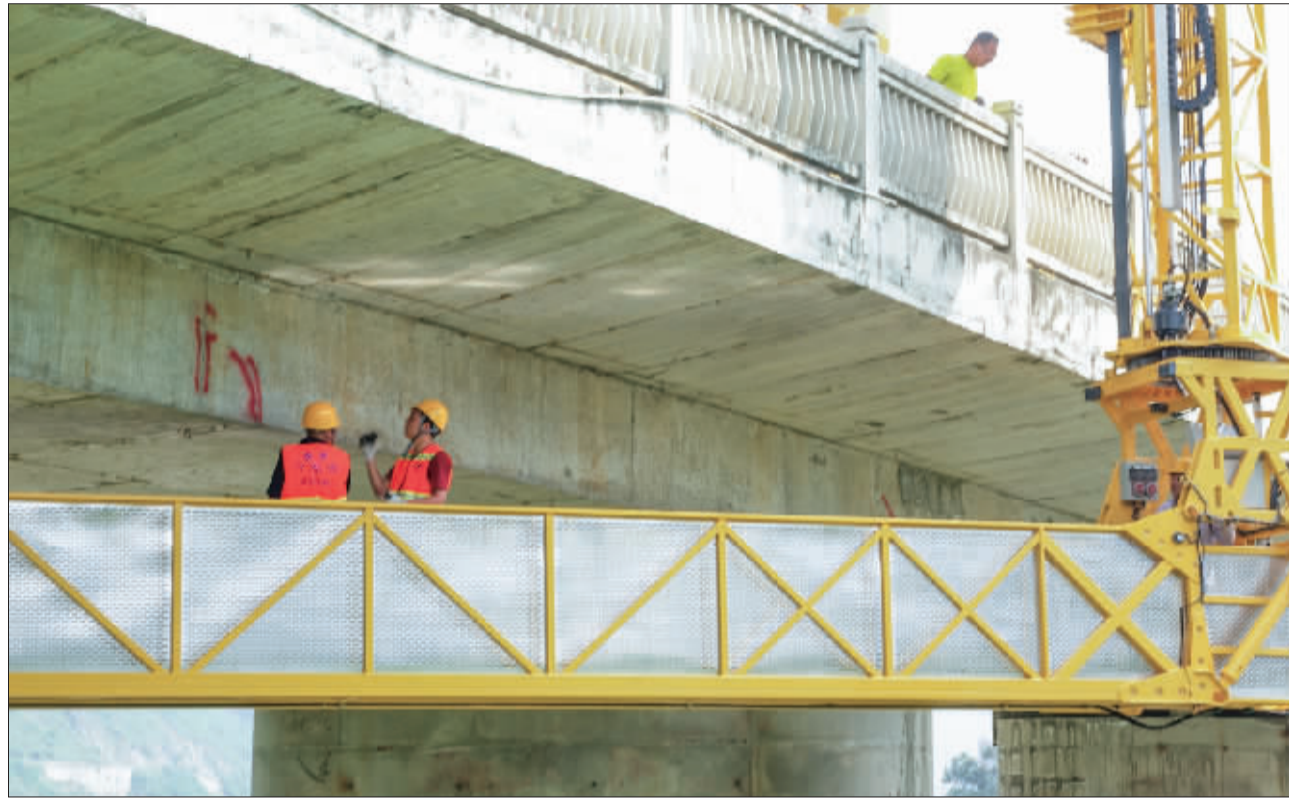
图为养护工人正在对桥梁进行检测。杨克勇摄
