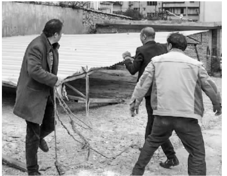
正在拆除违章搭建。
