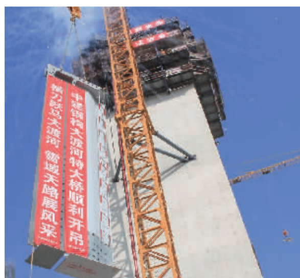
▲ 12 月 8 日，雅康高速泸定大渡河特大桥波形钢腹板顺利完成首次吊装。
