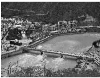
在建新城南大桥。
