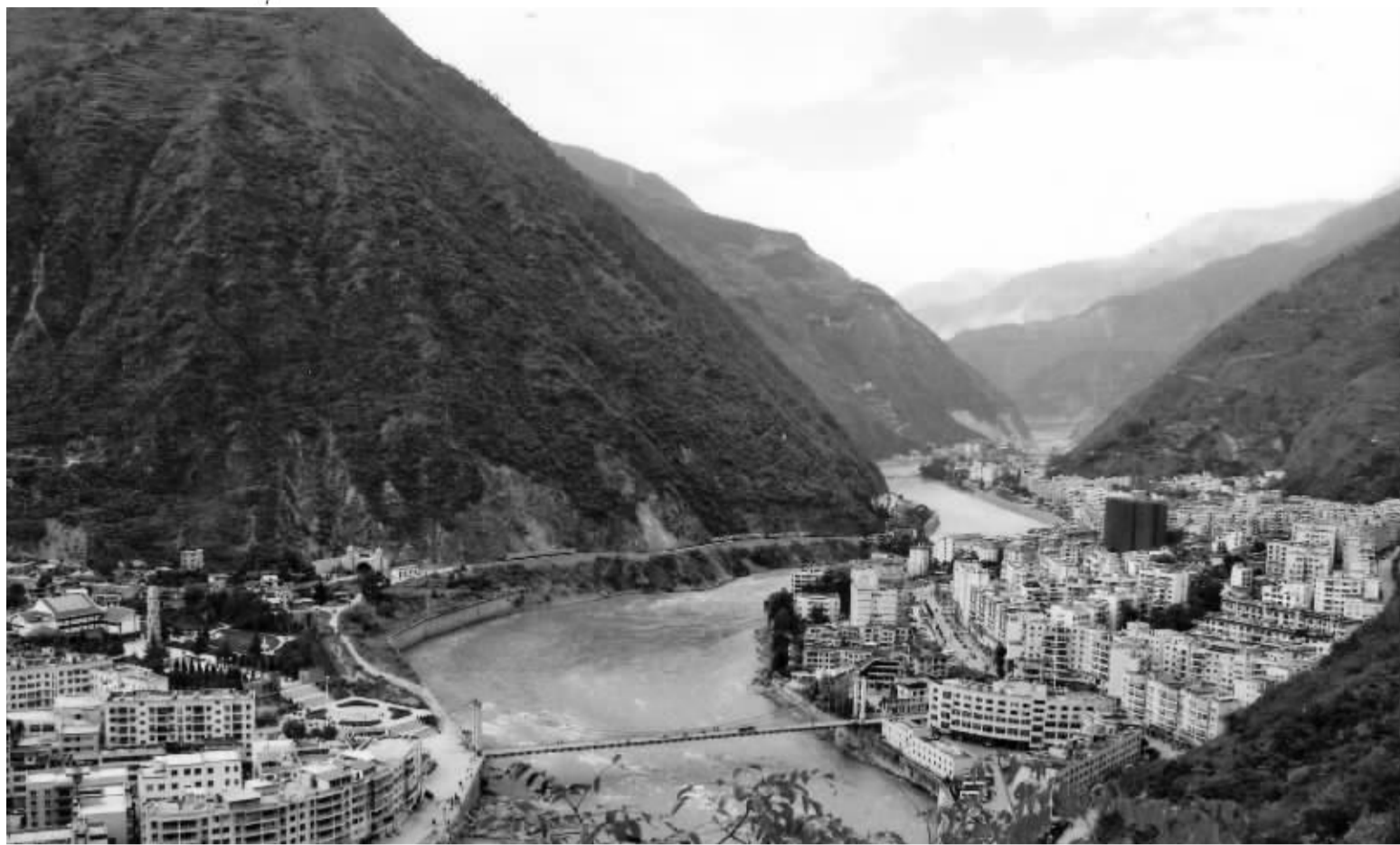
旧城南大桥全貌。
