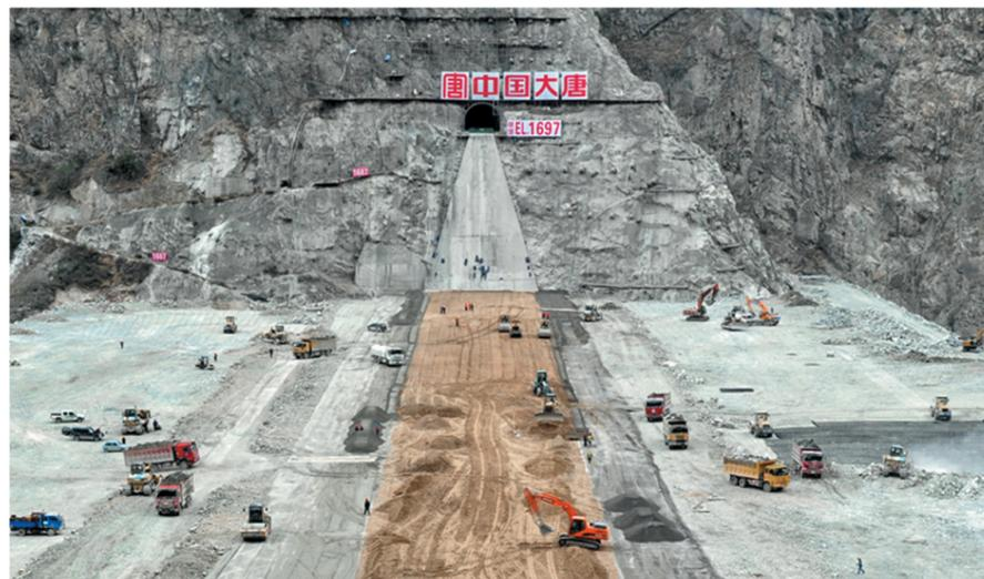
图为3月29日,长河坝大坝已填筑至1658.33米高程。
