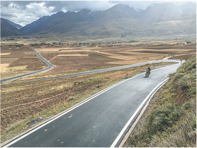
油路修到家门口。
