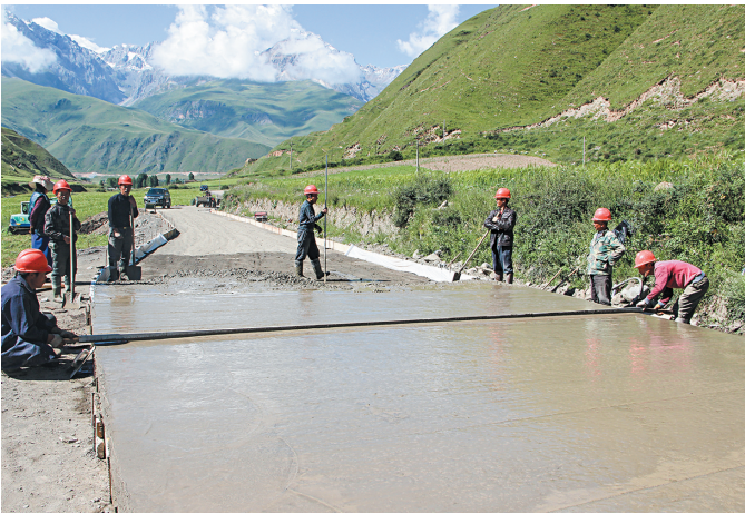
混凝土路施工。
