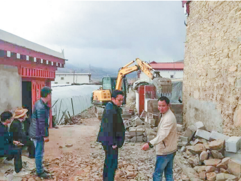
道孚县拆除违法建筑现场。
