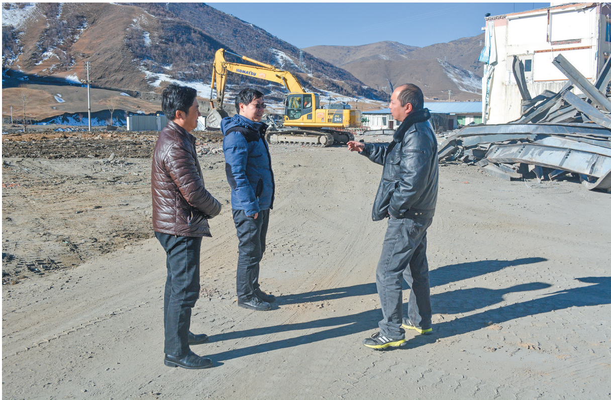
康定市工作组在拆迁现场开展工作。
