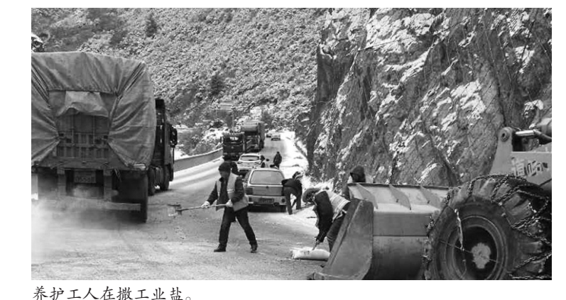
养护工人在撒工业盐。
