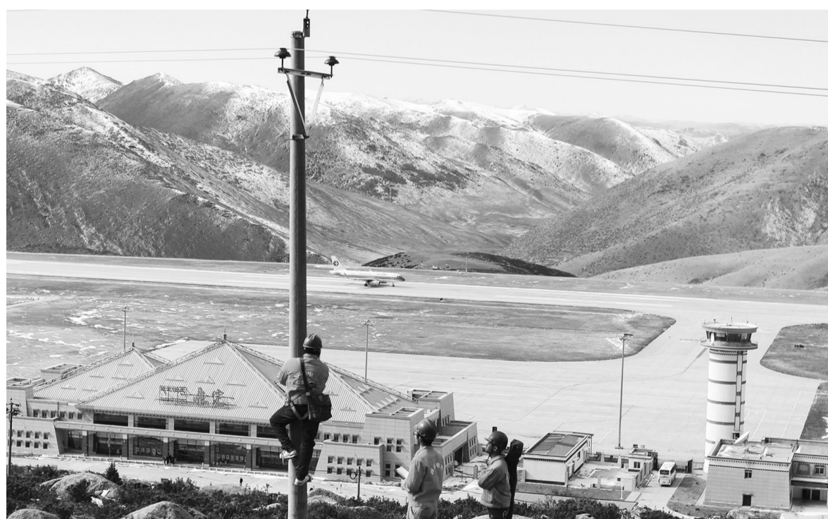
供电员工仔细巡视机场电力线路。
