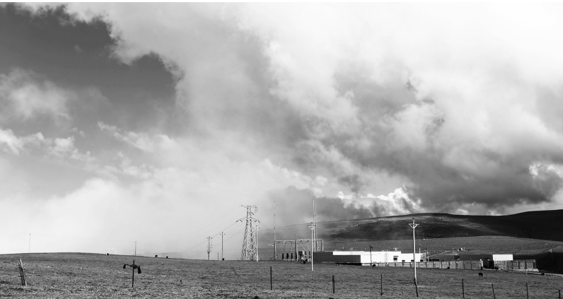
云端上的贡唐岗光伏电站。
