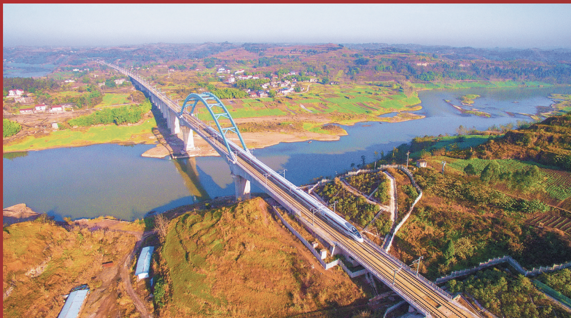
CRH380D 型高速动车组驶过资中成渝客运专线特大桥。何海洋 摄
