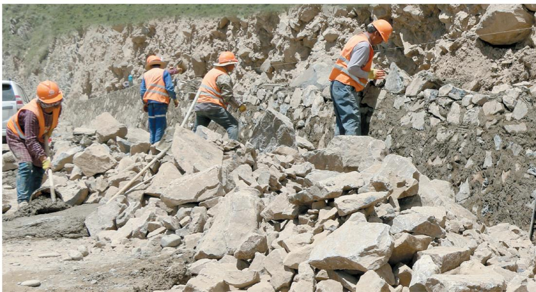
工人正在进行边坡护面墙施工。
