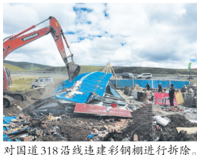
对国道318沿线违建彩钢棚进行拆除。
