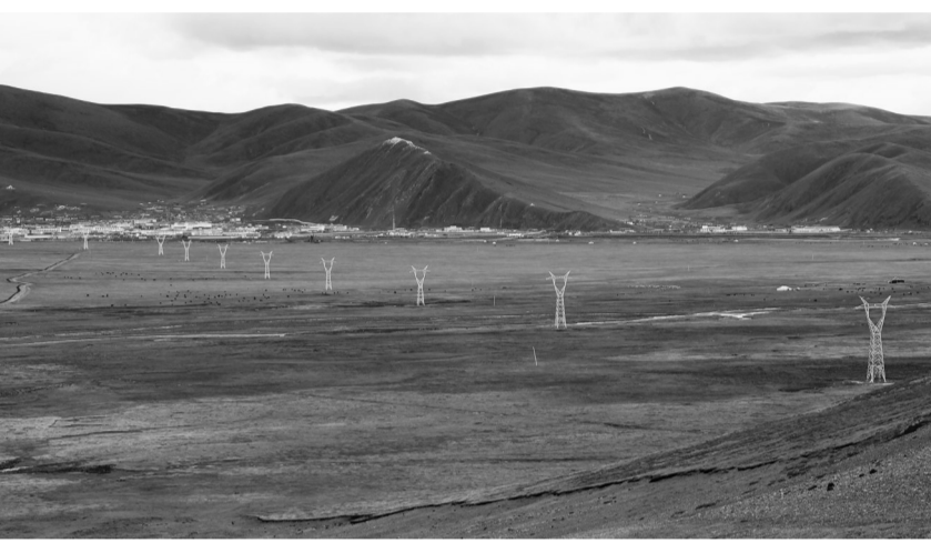
一基输电铁塔架入了新甘石终点石渠县。
