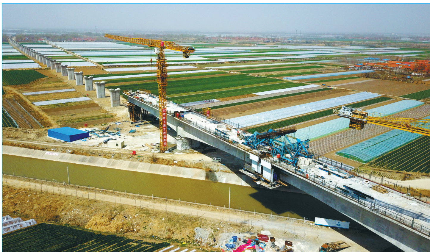
在山东省平度市明村镇,潍莱高铁跨胶东调水渠100米连续梁合龙。新华社发
